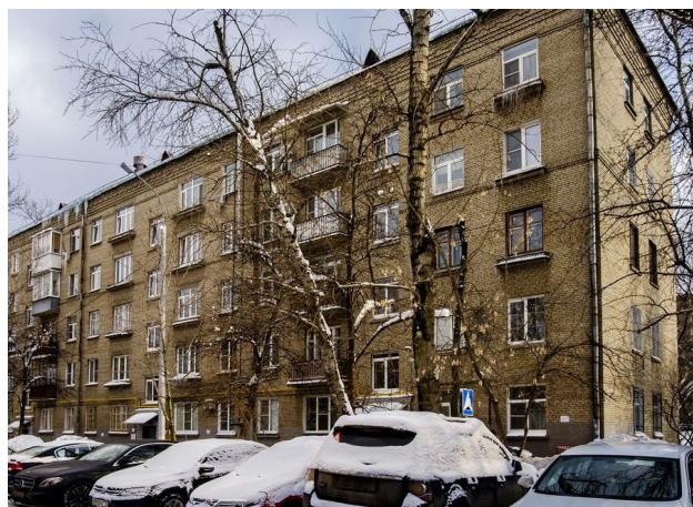
◆ Проектно-изыскательские работы и строительномонтажные работы для объекта: «Многократный жилой дом». Адрес: г. Москва, ЮЗАО, ул. Ивана Бабушкина 17, корп. 2.
